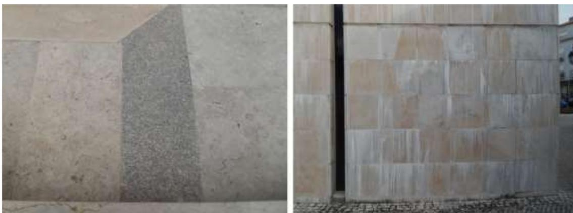
**Figura 9:** À esquerda: lioz (cor clara) e granito (cinzento) no pavimento na área exterior da igreja; à direita: exsudações de sais no revestimento calcário de uma parede. Fonte: autor.
